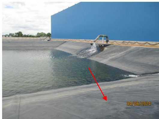
รูปที่ 3-23 การปูบ่อพักน้ำทิ้งด้วย HDPE
