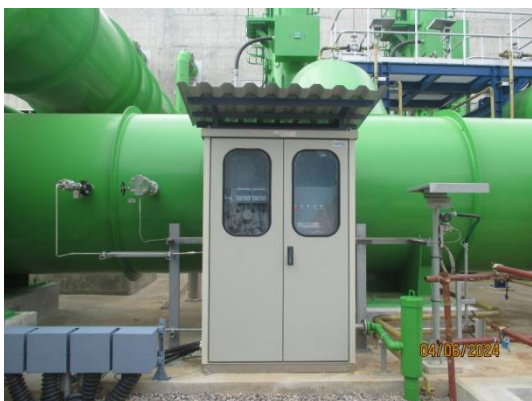
รูปที่ 3-24 ระบบ Online Monitoring บริเวณหอหล่อเย็น (Cooling Tower Basin)
