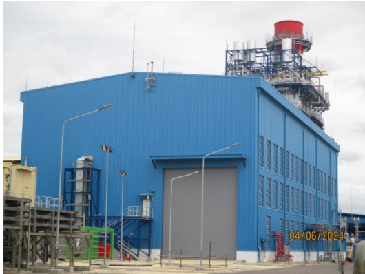
รูปที่ 3-12 Enclosure ครอบเครื่องจักรที่มีเสียงดัง
