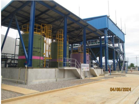
รูปที่ 3-41 ขอบกั้น (Dike) บริเวณพื้นที่กักเก็บสารเคมี
