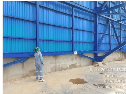
รูปที่ 3-15 เจ้าหน้าที่ทำการตรวจสอบกำแพงกันเสียงถาวร
