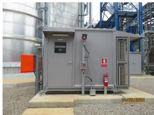
รูปที่ 3-5 เครื่องมือตรวจสอบคุณภาพอากาศแบบต่อเนื่อง (CEMS)
