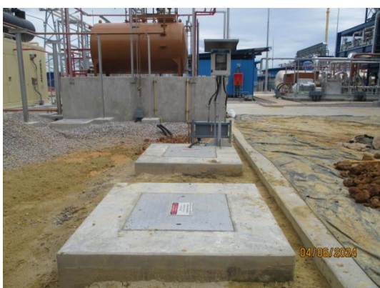
รูปที่ 3-26 บ่อแยกน้ำ/น้ำมัน (Oil Separator)
