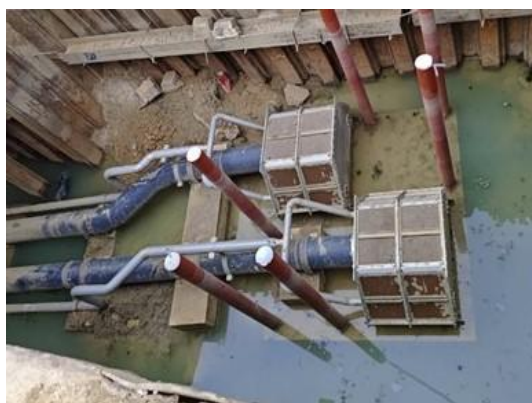
รูปที่ 3-20 ตะแกรงดักขยะที่ปลายท่อสูบน้ำบริเวณ แม่น้ำแม่กลอง
